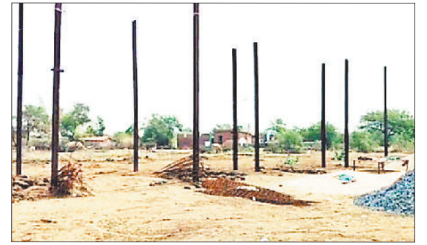
निर्माणाधीन सब स्टेशन।
